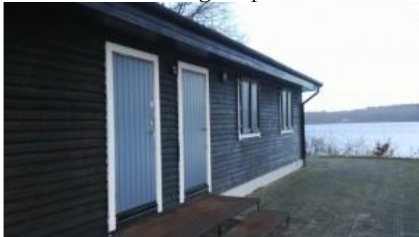
SÖ-fasaden bytt och hela huset är målat. Grunden är putsad. Nu ger vi oss på insidan.
